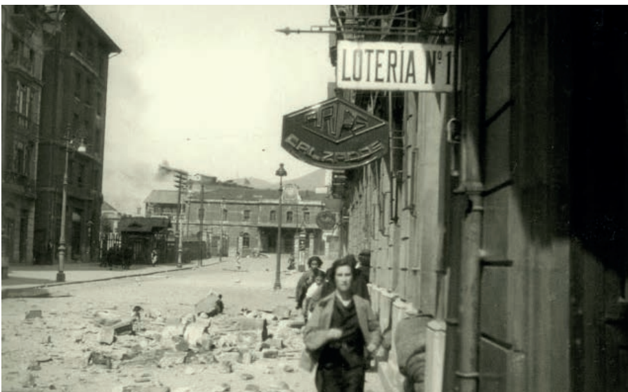
Calle Uría. Al fondo, la Estación del Norte
